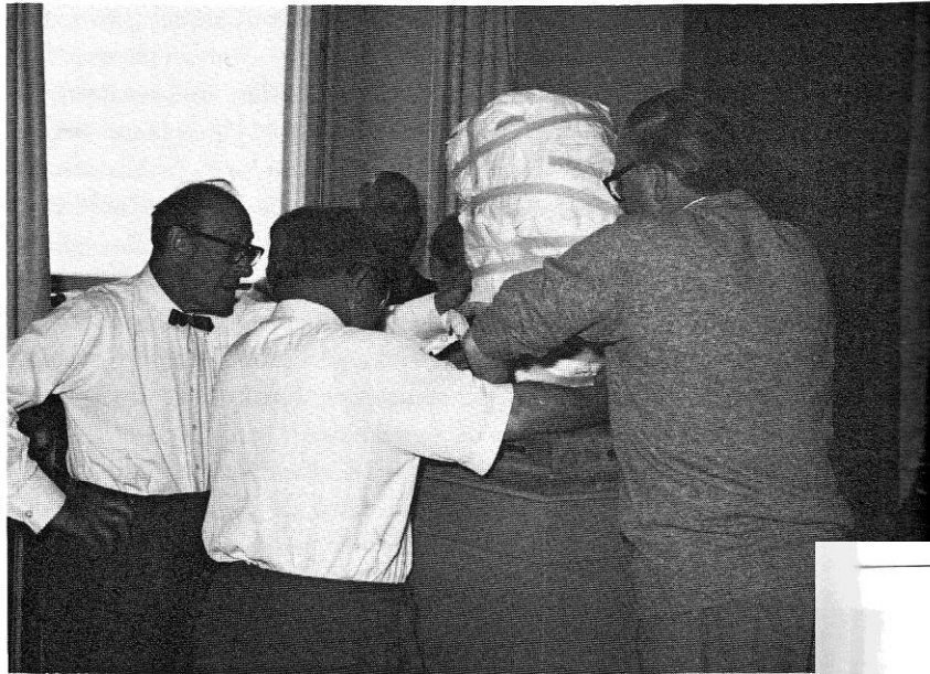
64 Rückführung der Nofretete-Büste aus dem Treuhanddepot in Wiesbaden am 23. Juni 1956. Entfernung der Verpackung durch die Restauratoren H. E. Sommerfeld und den Leiter i. R. des Chemischen Laboratoriums Prof.
